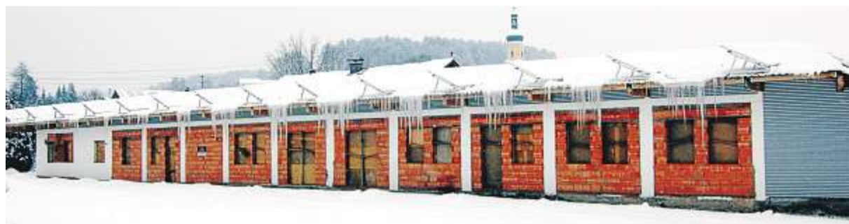
In der einstigen Schreinerei, die Thomas Welter erworben hat, entsteht das Gesundheitszentrum. Foto: Bergbauer
